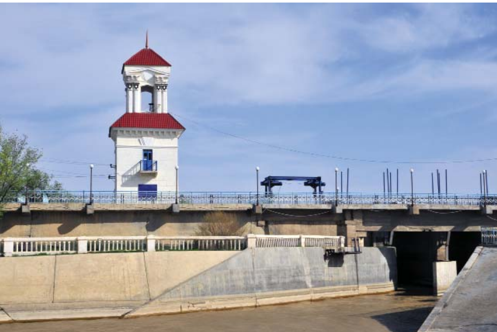
Кызылординское гидротехническое сооружение
